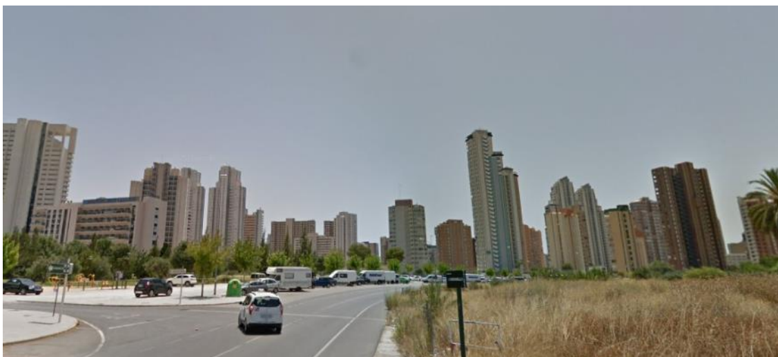
Ilustración 2 Avenida de la Carretera del Albir vista desde su entronque con el camino de Armanello, dejando a la izquierda el sector
